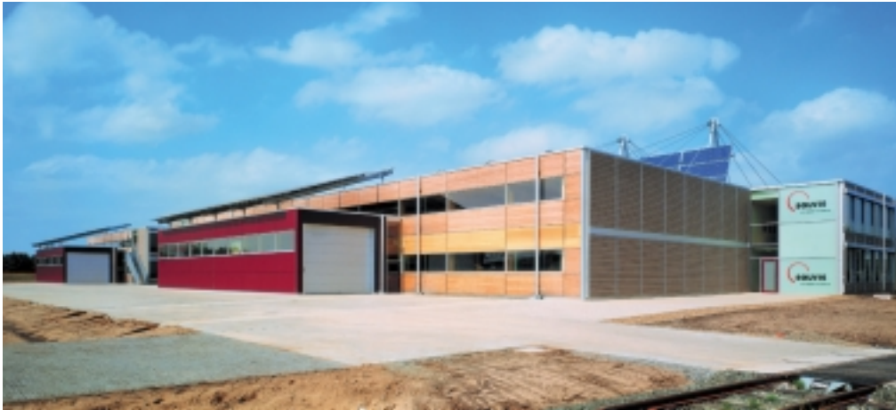
Foto 4: Ansicht von Südwesten.
